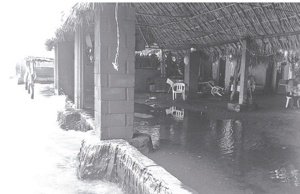
► Los propietarios piden ayuda por los daños a sus negocios.
