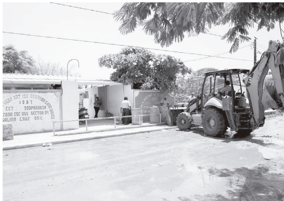
► La entrada al plantel permanece lleno de lodo.
