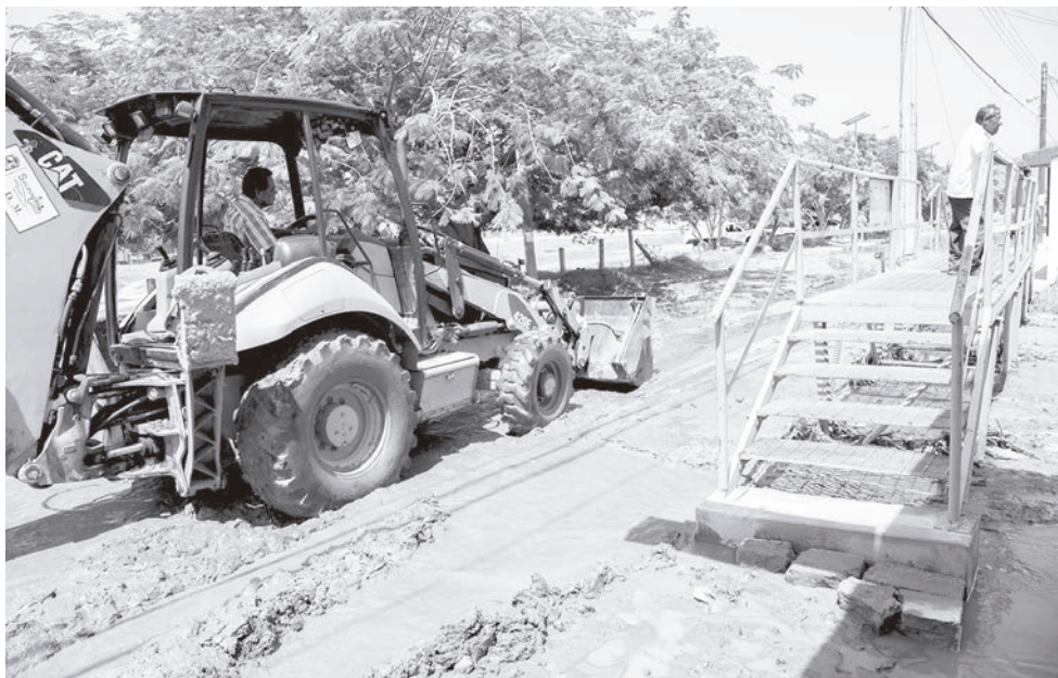
► Con maquinaria pesada quitan el lodo que obstruye el paso.
